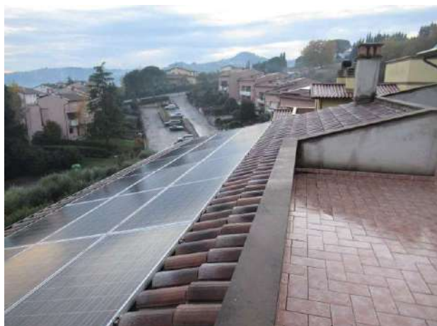
Foto n. 45: Impianto fotovoltaico
